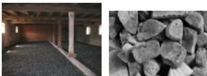
Einbau von GEOMATERIALS Schaumglas Typ S (als kapillARBRECHENDE, lastabtragende Wärmedämmung unter Gründungselementen)
