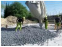
Einbau von GEOMATERIALS Schaumglas (als drainagierende, wärmedämmende Leichtschüttung)
