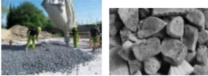
Einbau von GEOMATERIALS Schaumglas (als kapillarbrechende, lastabtragende Wärmedämmung unter Gründungselementen)
