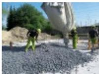
Einbau von GEOMATERIALS Schaumglas (als drainagierende, wärmedämmende Leichtschüttung)
