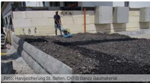
Foto: Hangsicherung St. Gallen, CH | © Ganze Baumaterial
