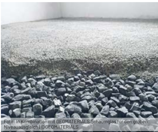
Foto: lose Dämmschüttung | ©Poraver
