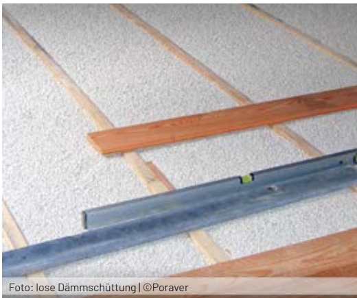
Foto: lose Dämmschüttung | ©Poraver
