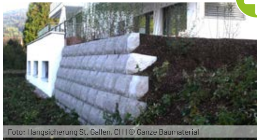
Foto: Hangsicherung St. Gallen, CH | © Ganze Baumaterial
