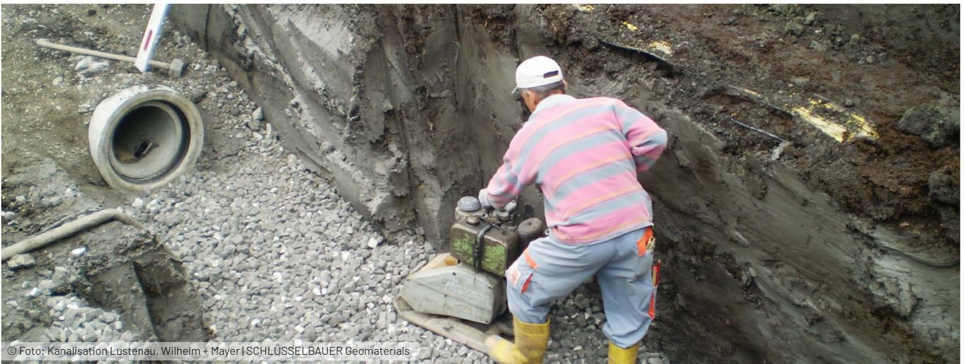
Durch seine besonderen Eigenschaften eignet sich **GEOMATERIALS Schaumglas** hervorragend für Fern- und Nahwärmeleitungen, sowie unterirdische Behälter wie z.B. Wasserspeicher oder Biogasanlagen, Übergabestationen und Verteiler. **GEOMATERIALS Schaumglas** bietet als Unterbau von Rohrleitungen bei schlechten Böden eine solide Basis und reduziert Wärmeverluste.
