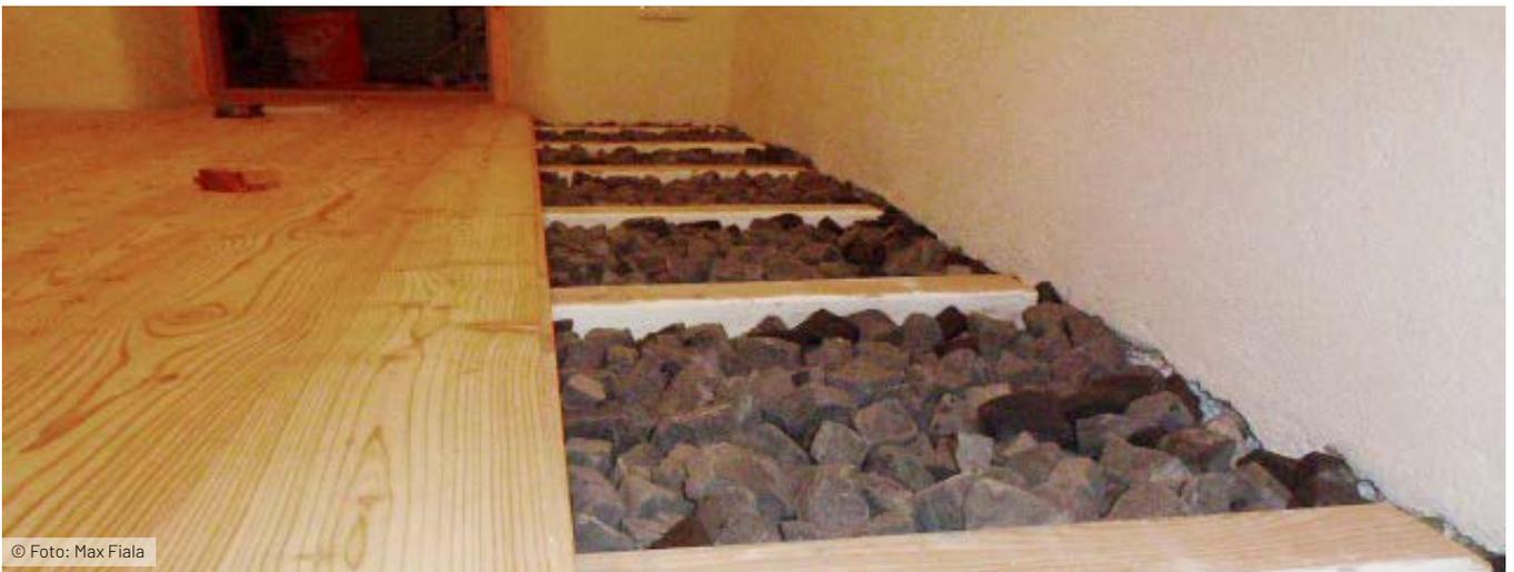
Der Fußbodenaufbau mit **GEOMATERIALS Schaumglas** eignet sich für Neubau und Sanierung. Besonders bei alten Gebäuden ist bei der Sanierung von Fußböden die verfügbare Aufbauhöhe begrenzt.
